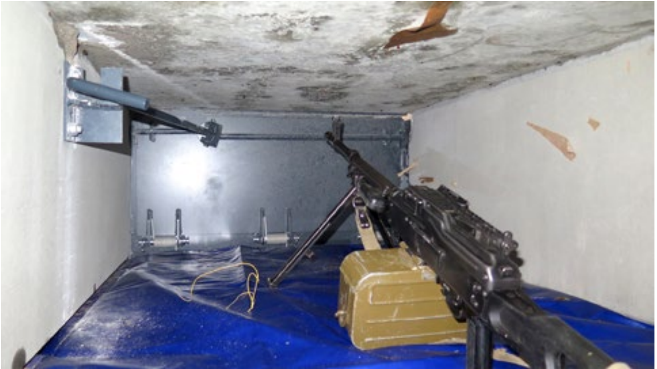
Kuva 3: T2Rk:n tuliaseaman pohja päällystettynä kevytpeitteellä. Aseistuksena asemassa PKM-konekivääri. (Kuva: Pioneerisektori)
