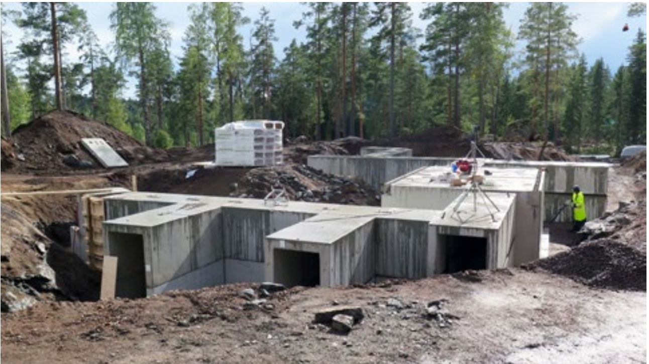
Kuva 1: T2Rk-linnoitustyömaa Haminassa elokuussa 2025. (Kuva: Pioneerisektori)
