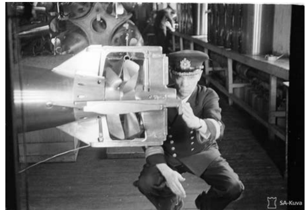
Torpedopajassa tarkastetaan ja todetaan jokaisen torpedon kunto. Helsingin Laivastoasema, 1942. (SA-kuva / Pauli J. Wiro)
