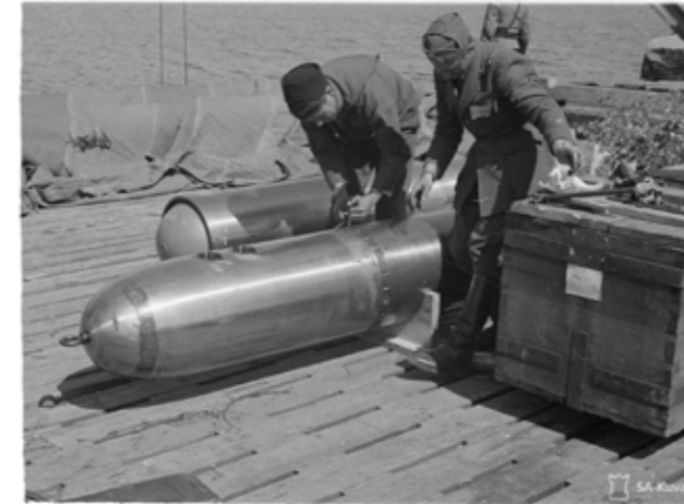
Torpedoon kiinnitetään etuosa räjähdysaineeseen. Lahdenpohja 1942. Kuva: SA-kuva.
