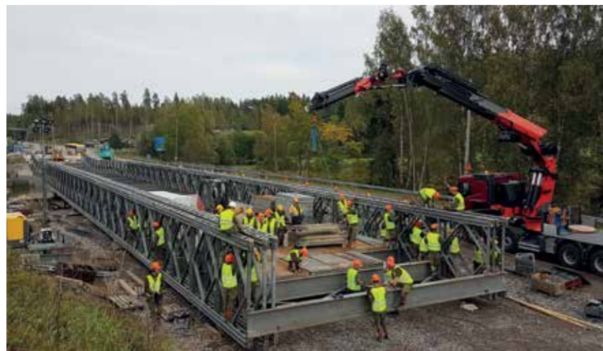
Käytäntö opettaa. Kymen pioneeripataljoona rakentamassa 72 metristä Universal-siltaa Porvoon Mustijoella syyskuussa 2018.
