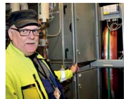
Kuvassa oleva lämmöntalteenottoyksikkö on Askon suosikki, kun siinä on parhaimmat talteenoton hyötysuhteet.
