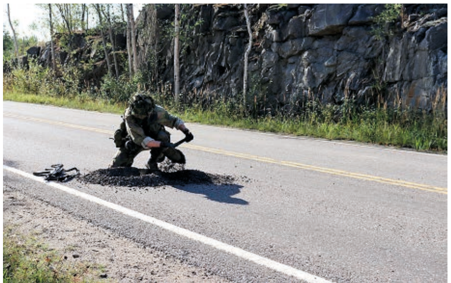
Pioneerit avaamassa kestopäällysteeseen valmisteltua miinasijaa
