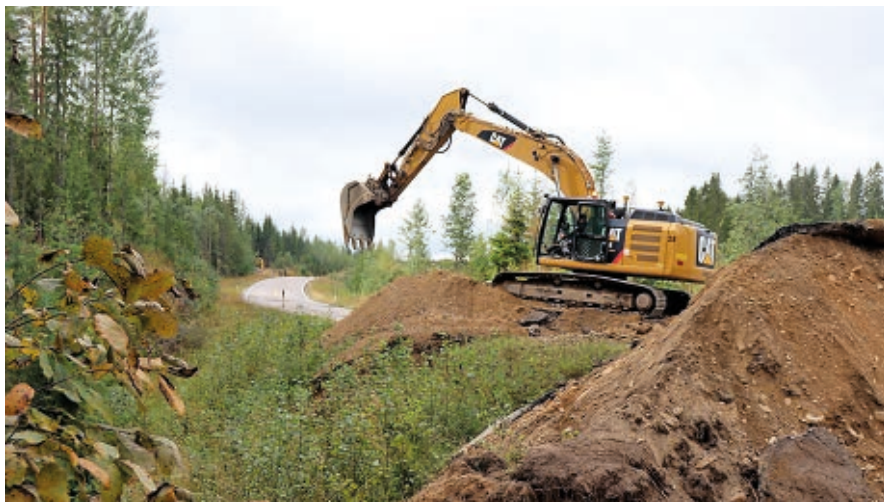
Aluerakentajan työkone valmistelemassa panssarikaivantoa
