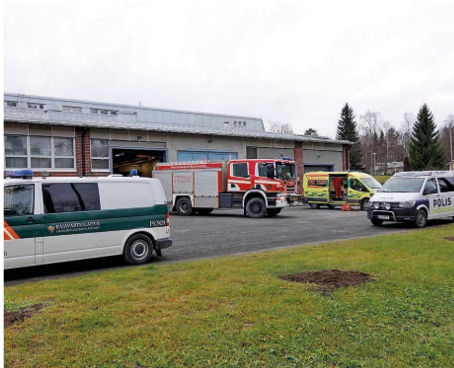
Ilomantsin Turvatalolla sijaitsevat rajavartioston, poliisin ja pelastuslaitoksen toimitilat
