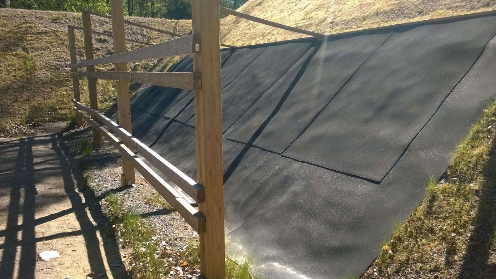
Kuva 3.6. Kumimattorakenne taustavallin päällä Tammelan kivääriradalla
