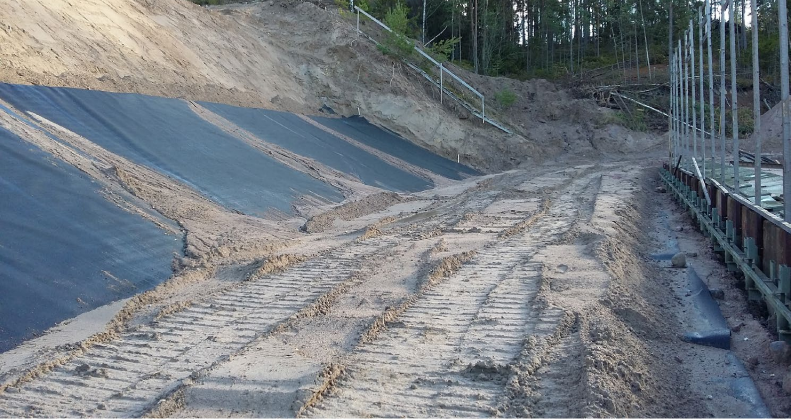
Kuva 3.4. Tiivisrakenne taustavallin sisällä asennusvaiheessa Baggbyn ampumaradalla
