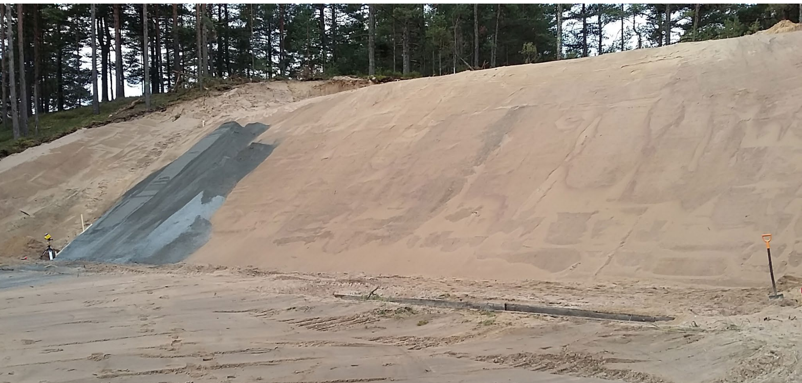
Kuva 3.5. Kivituhkan asentaminen taustavallin pintaan Syndalenin ampumaradalla
