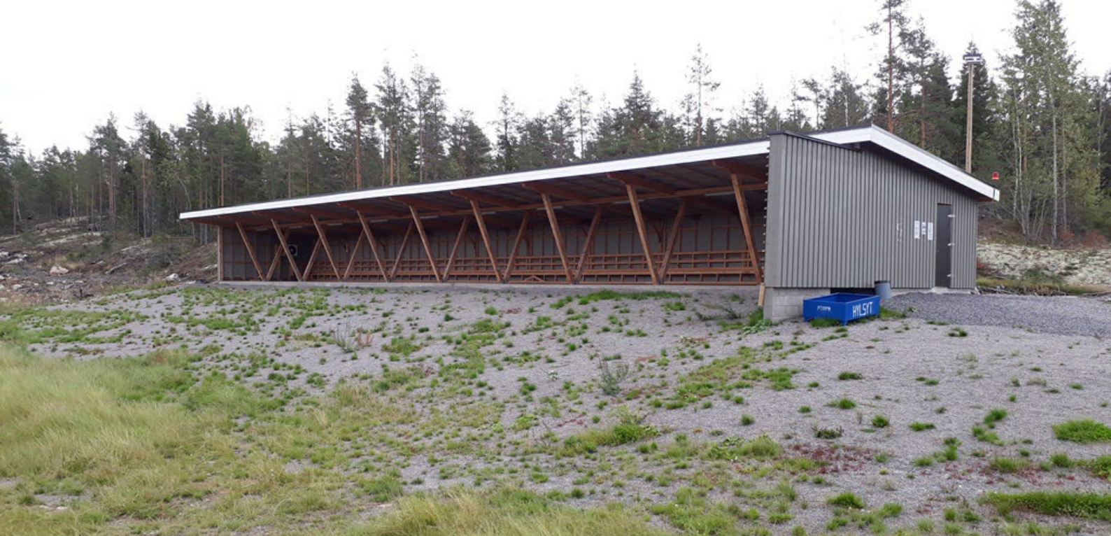
Kuva 3.3. Meluseinäke Raasin ampumaradalla 300 metrin kivääriradan ampumakatoksen päädyssä
