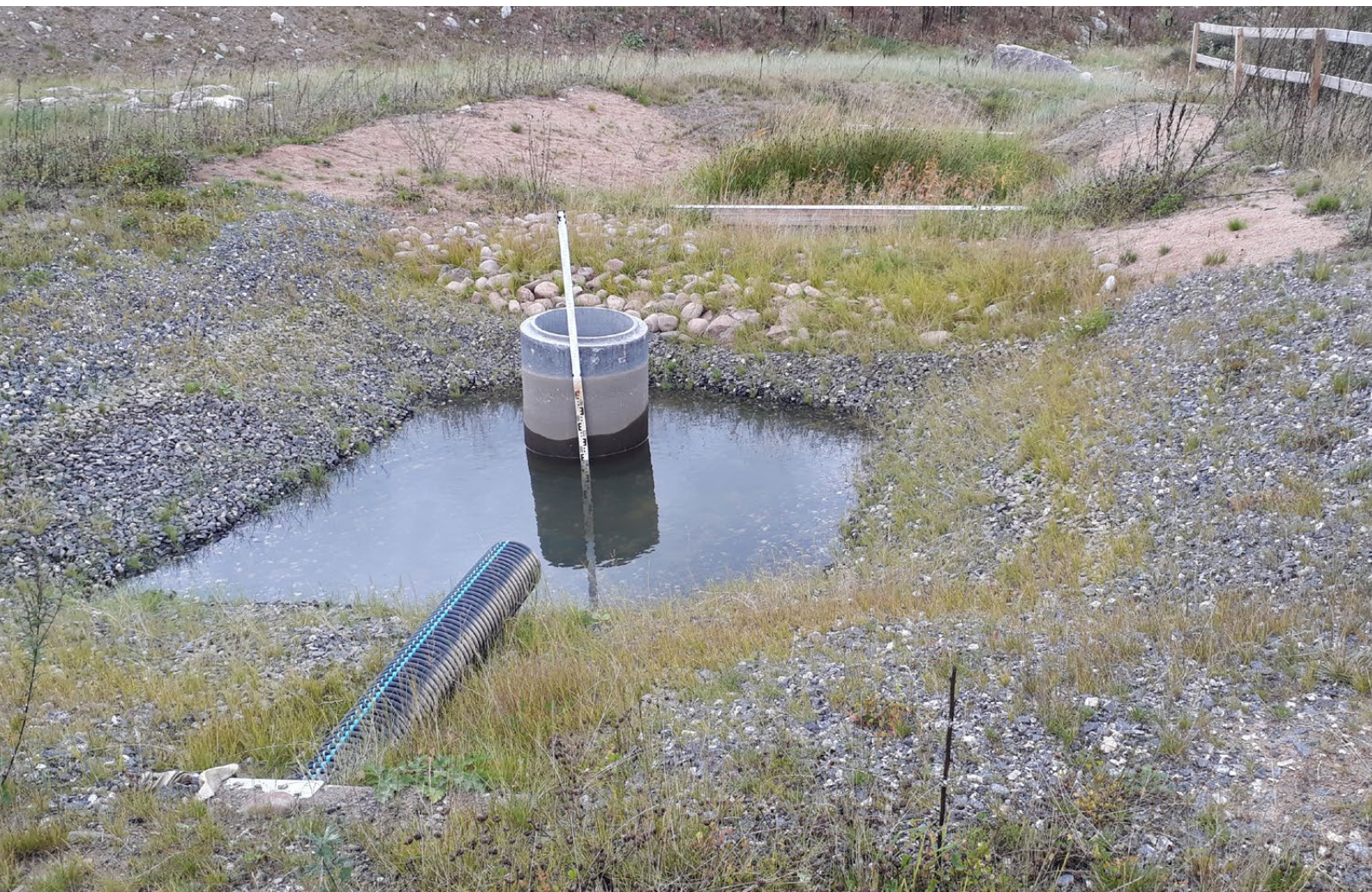
Kuva 3.9. Kolmivaiheinen allaskäsittely Raasin ampumaradalla
