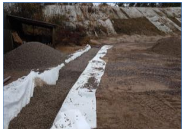
Tilanneradan salaojan asennus
