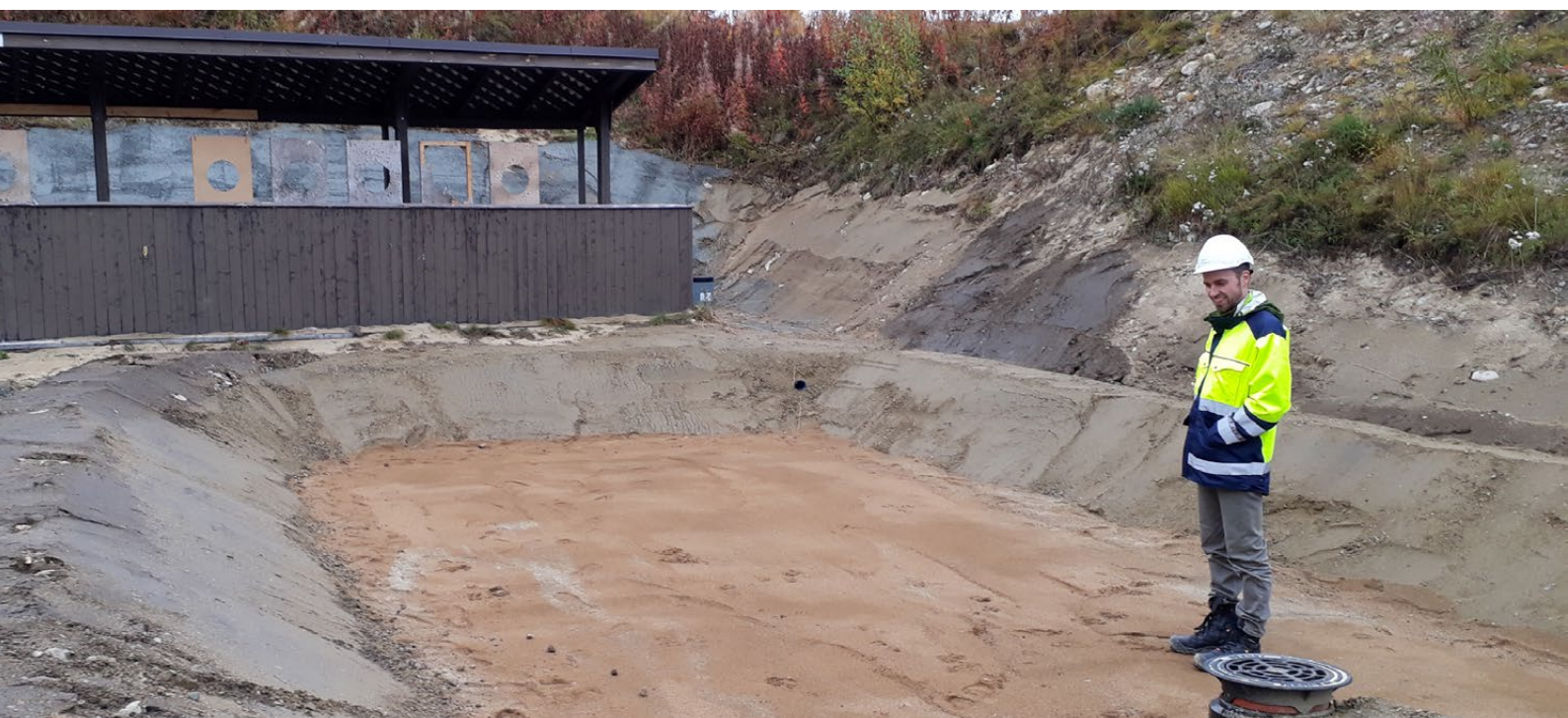
Kuva 3.8. Projektipäällikkö Teemu Hourula tarkastamassa laskeutusallasta ennen käyttöönottoa
