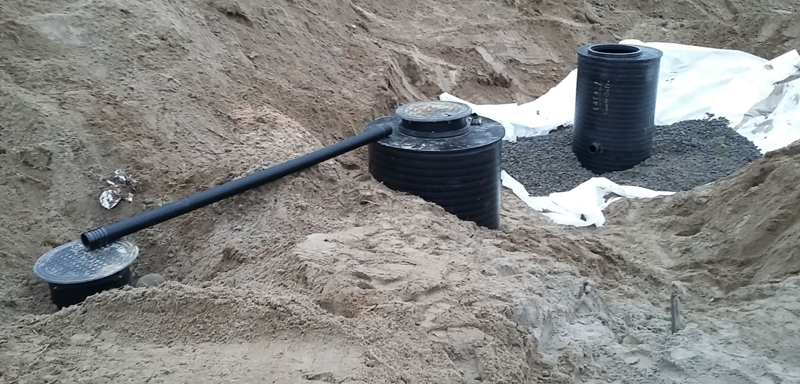
Kuva 3.10. Kaivojärjestelmä asennusvaiheessa. Kuvan järjestelmässä vain yksi käsittelykaivo (keskellä).
